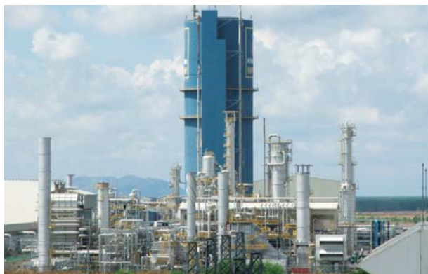
Nhà máy Đạm Phú Mỹ. Ảnh: PVFCCo
