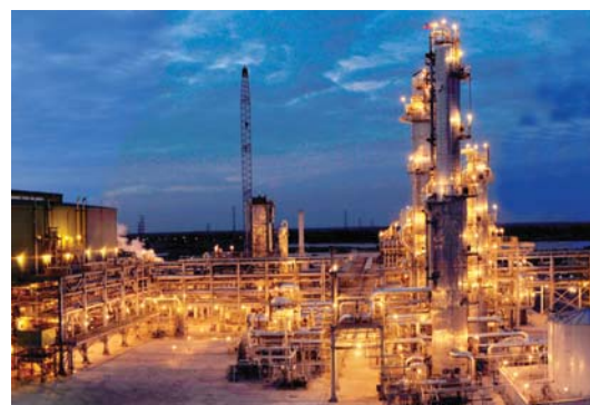
Nhà máy Đạm Cà Mau. Ảnh: PVCFC
